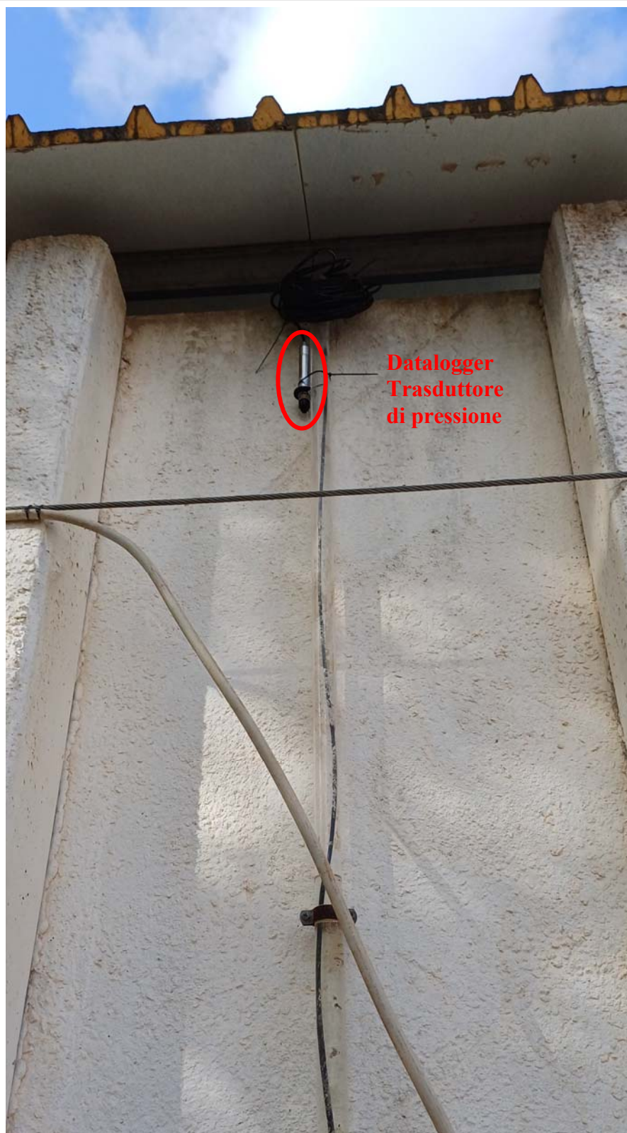
Foto 1 – Particolare installazione Trasduttore di pressione Vasca prima pioggia
